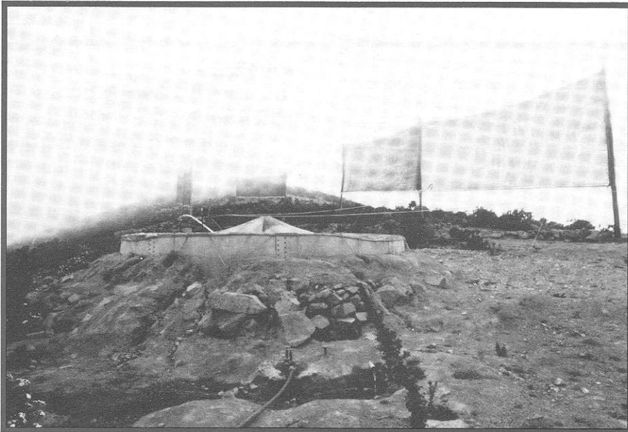
*El agua de neblina se recolecta en mallas verticales hechas de polipropileno y después se canaliza hacia el poblado por tuberías.*
