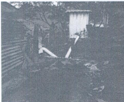
Figura N° 9. Letrina instalada directamente al biodigestor. Taupaz, Siguatepeque.
