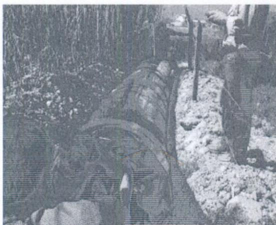
**Figura N° 7.** Instalación de un Biodigester\_Tipo Taiwán, Instituto Técnico Federico C. Canales, Jesús de Otoro. Foto: Osorio, P. 2008
