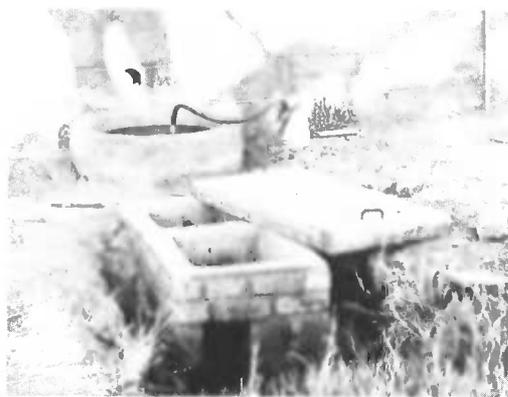
Fig. 4. Digesteur anaérobie avec drain d'infiltration. La photo montre le digesteur, le bassin de sortie et la sortie du trop-plein. On voit que le drain d'infiltration n'a pas encore été installé.
