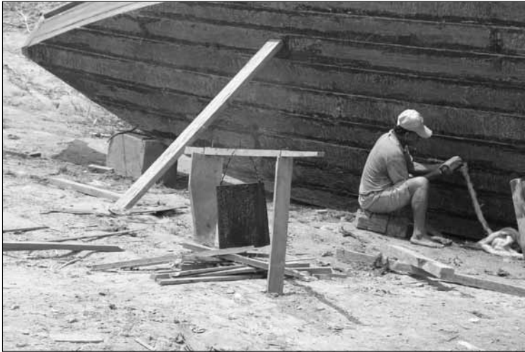
Reparación de barcos empleando estopa y alquitrán. Fotografía: Claudia Coca.
